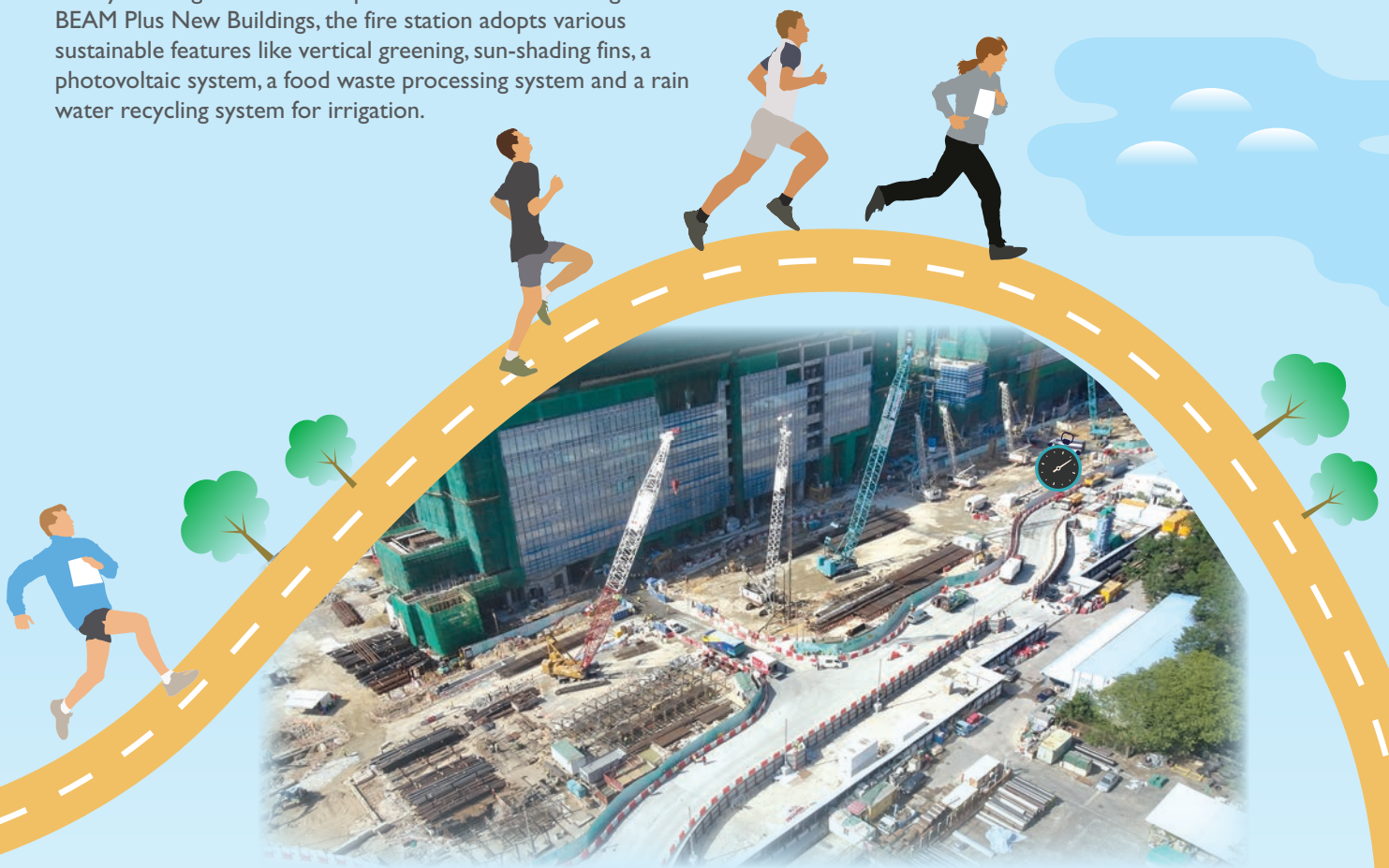
正進行的承昌道重建及地下結構興建工程
