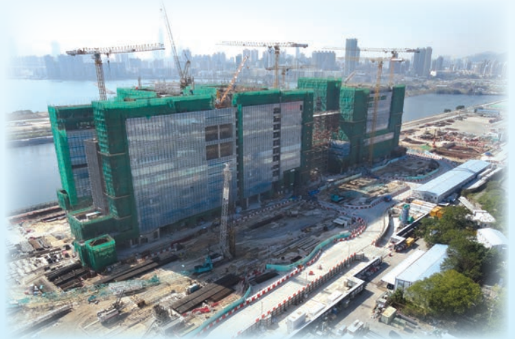
興建中的香港兒童醫院 The HKCH under construction
