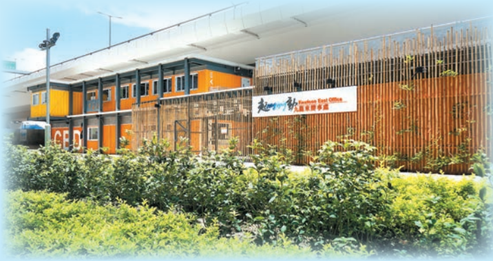
位於觀塘繞道下的起動九龍東辦事處臨時辦公室 The temporary office of EKEO underneath Kwun Tong Bypass
