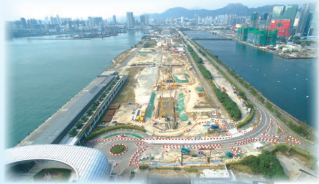
進行中的第二期基礎設施工程 Stage 2 infrastructure works under construction
